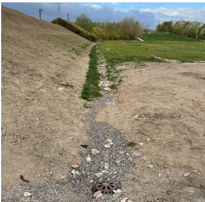
Figur 8. Bullervall och dike sett österifrån.
